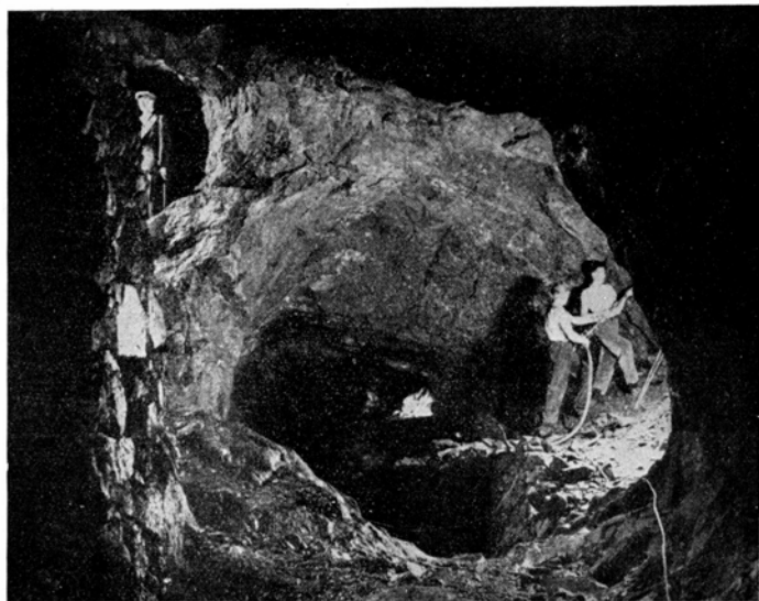
Ripresa nell'antico cantiere Cava Grande Miniera di Traversella (Soc. Fiat)
