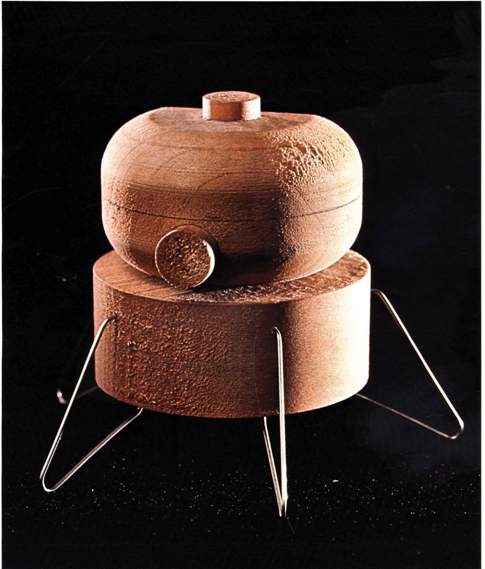
Questo è il primo « bozzetto » del LEM, come fu realizzato in legno otto anni fa da John Houbolt, un ingegnere americano allora del tutto sconosciuto.
