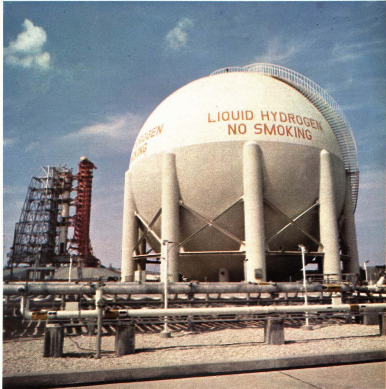
A sinistra, tecnici al lavoro intorno ai motori del primo stadio del missile che porterà Armstrong, Aldrin e Collins sulla Luna. Sotto, un deposito di idrogeno liquido, sostanza che serve a costituire il propellente per alcuni motori del missile. Nello sfondo, la rampa di lancio numero 39, da dove partirà il volo lunare.
