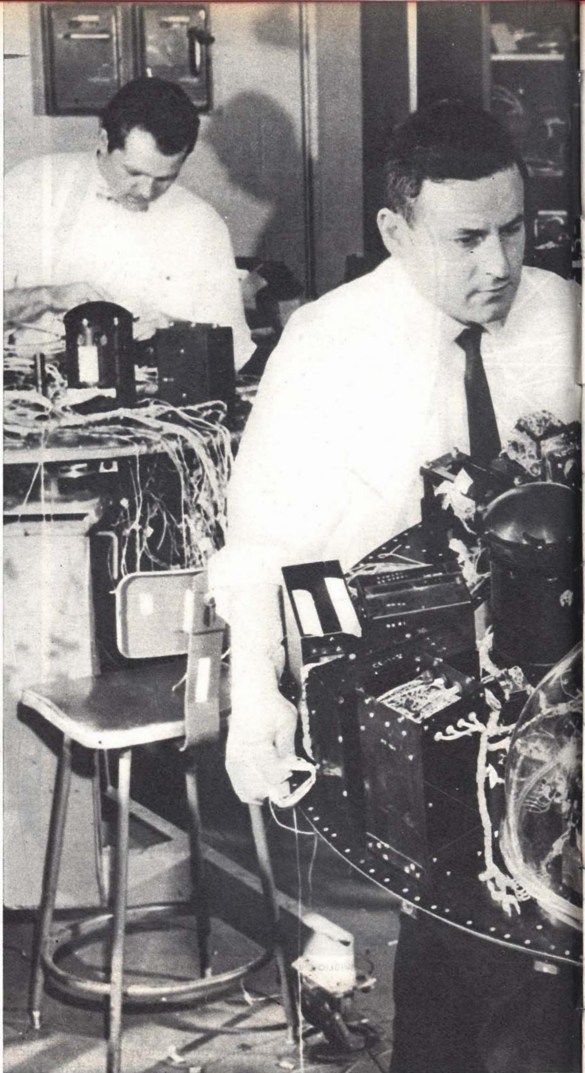
Un gruppo di specialisti americani monta in laboratorio i 15 mila pezzi della centrale telericevente e teletrasmittente del satellite. Telstar ruota dal 10 luglio attorno al globo con un'orbita ellittica che oscilla tra un minimo di 965 km. e un massimo di 5632.
