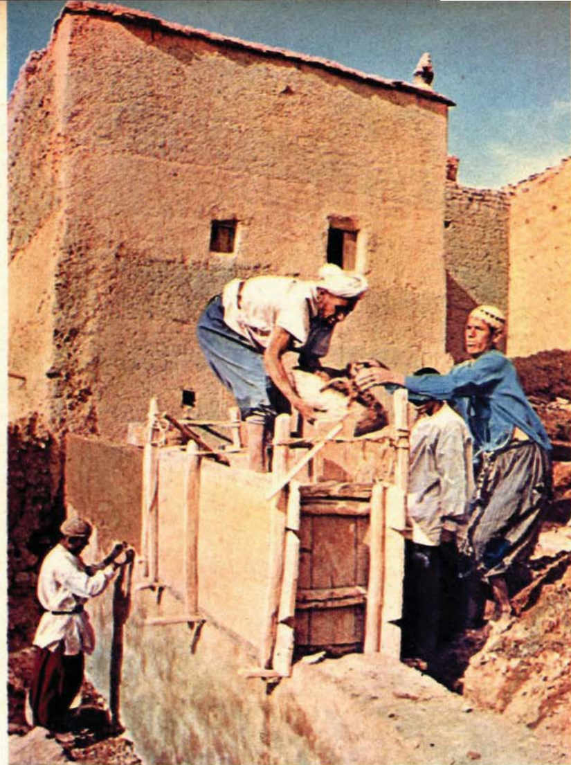
COSÌ COSTRUISCONO LE LORO CASE con forme di legno che riempiono di fango pressato, una accanto all'altra. Levate le forme, il muro è fatto. Ma, rapidamente come viene su, può anche precipitare.
