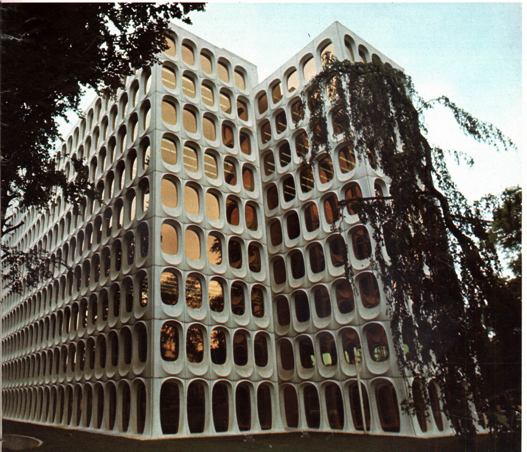
Ogni cellula di questo alveare è stata montata sul posto già completa di serramenti. Il C.B.R. è uno dei tanti complessi futuristi di Bruxelles.
