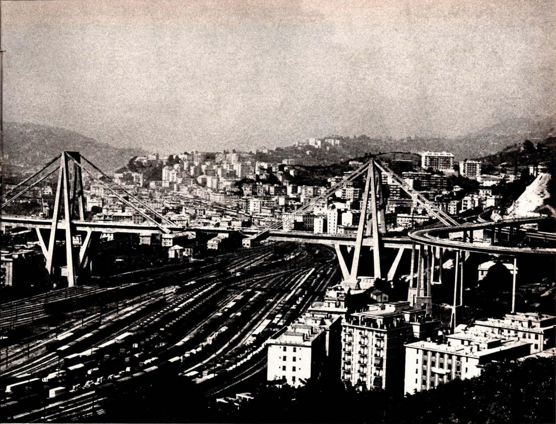
*Il viadotto è costato tre miliardi e mezzo di lire. Ogni pilone posa su un basamento di pali d'un metro e mezzo di diametro che si spingono a 46 metri di profondità.*
