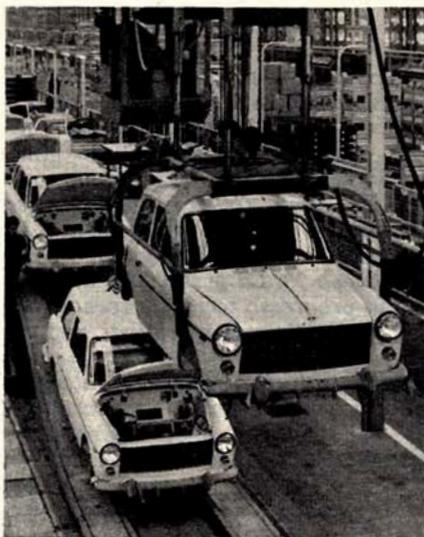
La catena di montaggio delle automobili nella fabbrica Innocenti di Lambrate: ogni sette minuti nasce una vettura.
