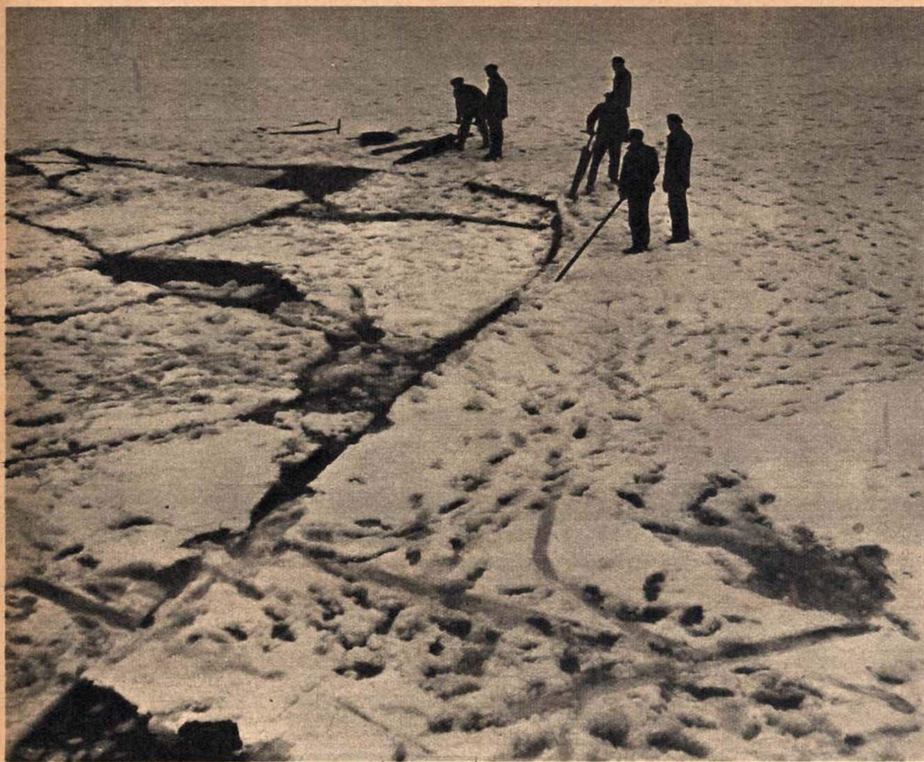
Si taglia il ghiaccio per preparare la pista di partenza, che naturalmente deve essere compatta e liscia. Per alcuni giorni i marinai del « Farm » lavorano senza soste per apprestare un'invasatura sulla grande distesa ghiacciata del fjord.
