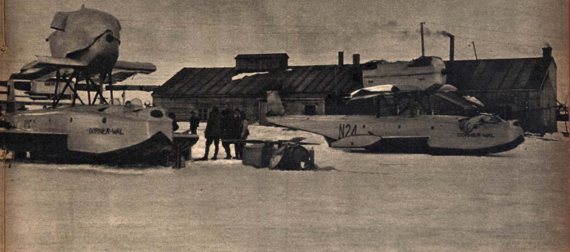
cina di montaggio. I due «Dornier-Wal» vennero costruiti dalla S.A.I. di Costruzioni Meccaniche a Marina di Pisa, con qualche piccola modifica di dettaglio rispetto agli motore Rolls Royce, modello «Eagle X». I due idrovolanti erano del tipo a battello centrale unico in alluminio speciale durissimo, senza pattini e senza galleggianti laterali.
