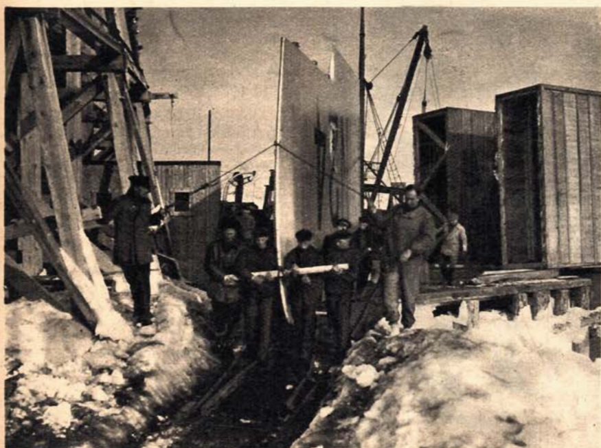
Le ali dei due aerei, tolte dalle casse, vengono portate al luogo di montaggio, lontane dalla banchina. Il tempo è favorevole: bisogna accelerare il lavoro.
