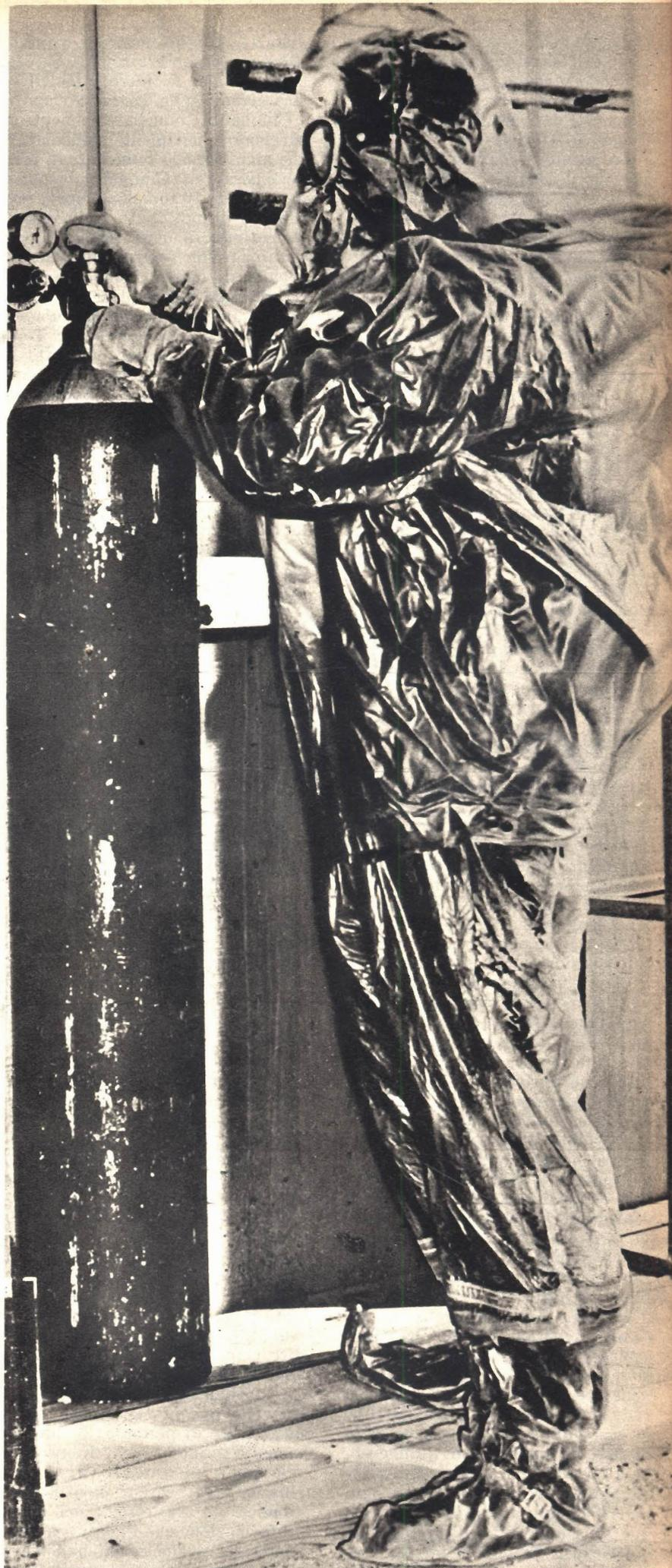
Uno dei tipi di abiti usati al Laboratorio Scientifico di Los Alamos, nel Nuovo Messico, per proteggere gli operai dall'atmosfera contaminata dalla radioattività. L'abito, o tuta, è fatto interamente di plastica. Nella superbomba al deuterio la distruzione è quasi interamente dovuta alla radioattività sprigionata, e in piccola parte allo spostamento d'aria o all'ondata di calore.
