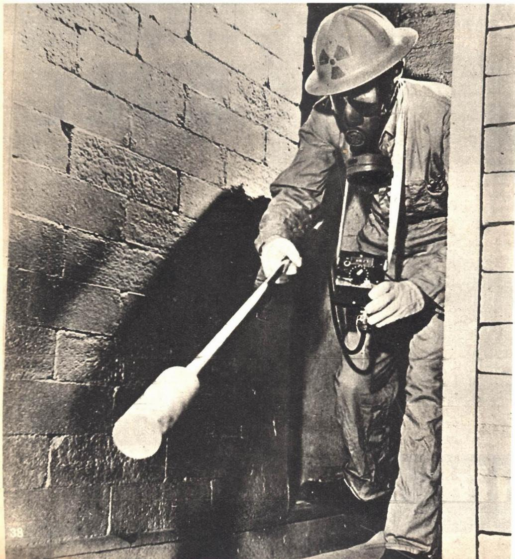
Esercitazioni antiradioattività in America. Per la protezione gli uomini usano casco, tuta, guanti, sovrascarpe di gomma e maschera. La sonda dal lungo manico trasmette all'apparecchio tenuto a tracolla l'intensità residua di radioattività rimasta nei materiali dopo l'esplosione.
