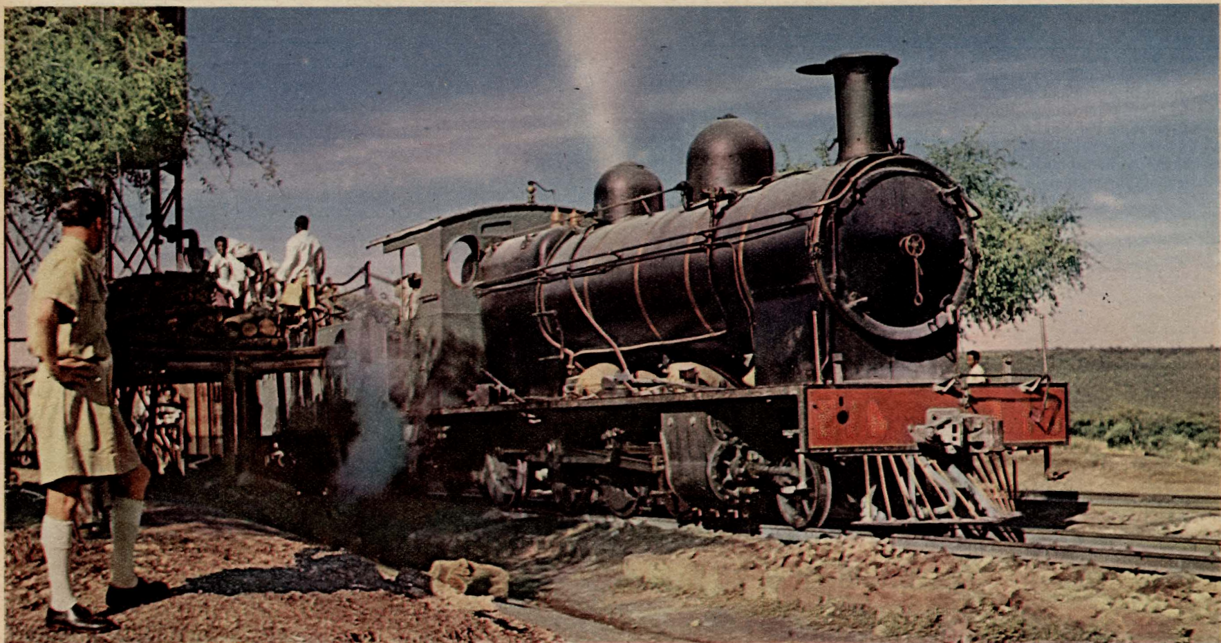
LA FERROVIA DI GIBUTI È LA VIA DELL'ETIOPIA AL MARE. COSTA MENO SPEDIRE CERTI ARTICOLI DA NEW YORK A GIBUTI CHE DA GIBUTI AD ADDIS ABEBA
