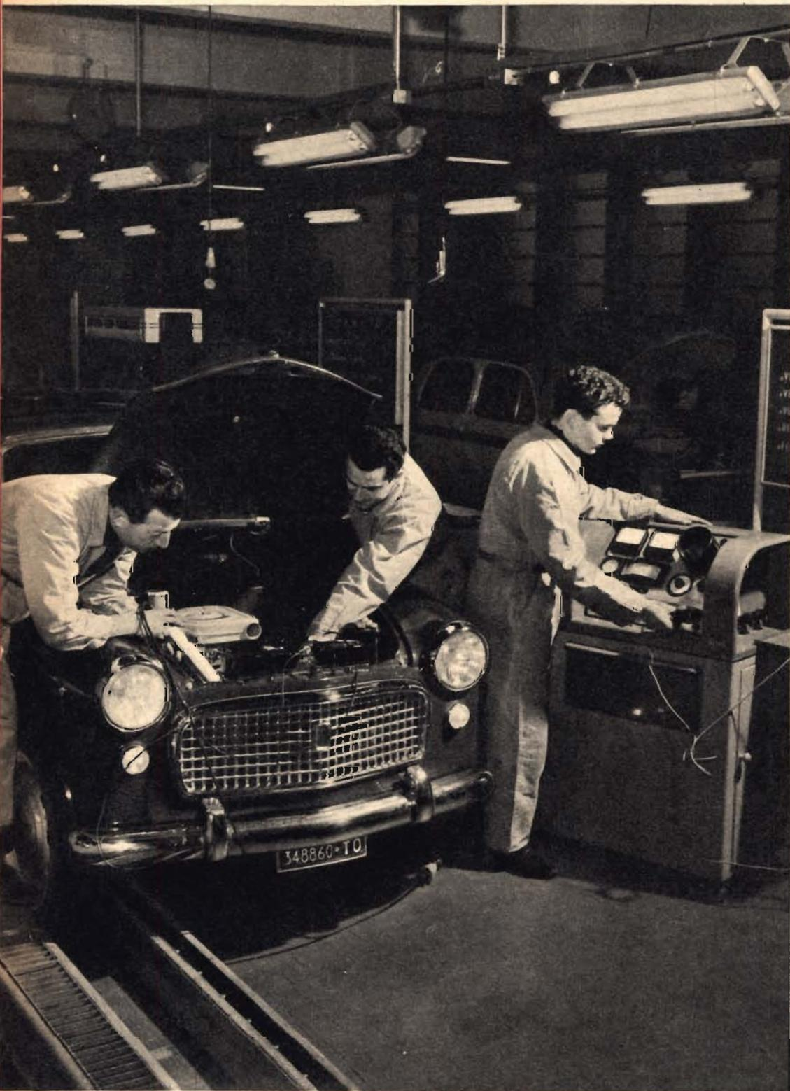
**IL CONTROLLO DELLA « FASE »** richiedeva, un tempo, un paziente lavoro. Per vedere se la scintilla scoccava al momento giusto, bisognava smontare la calotta dello spinterogeno e far girare il motore, a mano, alla ricerca di certi segni di riferimento. Oggi un apparecchio elettronico controlla l'esatta « messa in fase » e fornisce dati sull'intero impianto di accensione.
