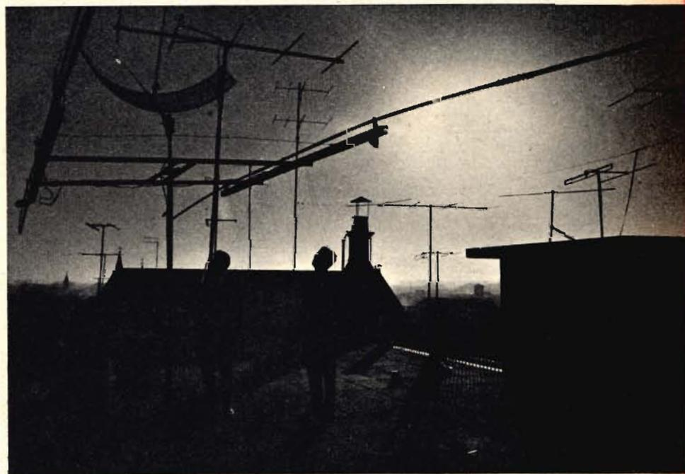
**LE ANTENNE** sono poste su un ampio terrazzo. Quella per l'ascolto dei satelliti è costituita da due elementi, che costantemente ruotano sul proprio asse per localizzare la provenienza delle onde. Ha un'apertura di due metri ed è mantenuta sotto costante controllo, per la giusta posizione, da un apparecchio televisivo che trasmette le immagini ai due radioamatori all'opera nella loro stazione.
